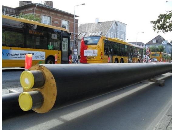
Figura 6 Tubería pre-aislada doble.
